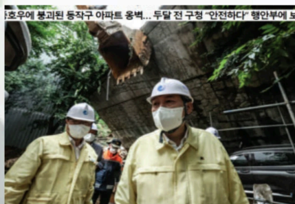
<사당동 동작구 아파트 옹벽 급경사지>
