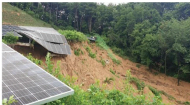
그림 1. 태양광 발전시설 주변 사면파괴(강원특별자치도 횡성군)
