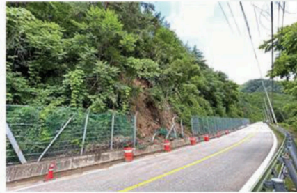
<NDMS 안전점검 결과 '안전' → 붕괴발생 사례>
