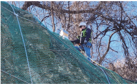
전문가 현장자문을 통한 상시계측관리시스템 검수 및 시운전
