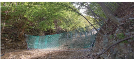
토석류 대책시설형 시공사례 (경북 경주시)
