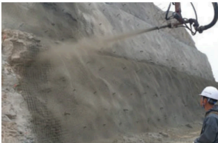
비탈면 보강 및 숏크리트 벽체형성
