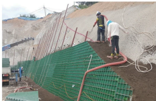
식생기반재 및 GREEN 패널 설치
