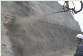
비탈면 보강 및 숏크리트 벽체형성
