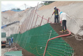
식생기반재 및 GREEN 패널 설치
