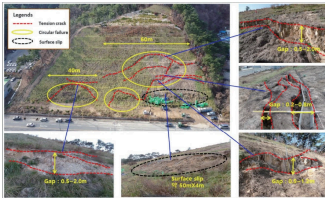
그림 3. Slope damage caused by land creep
