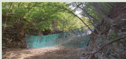
토석류 대책시설형 시공사례 (경북 경주시)
