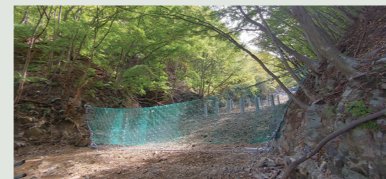
토석류 대책시설형 시공사례 (경북 경주시)
