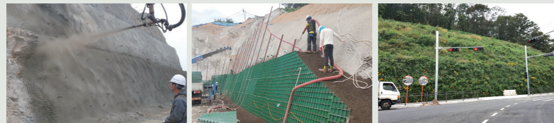
비탈면 보강 및 숏크리트 벽체형성
