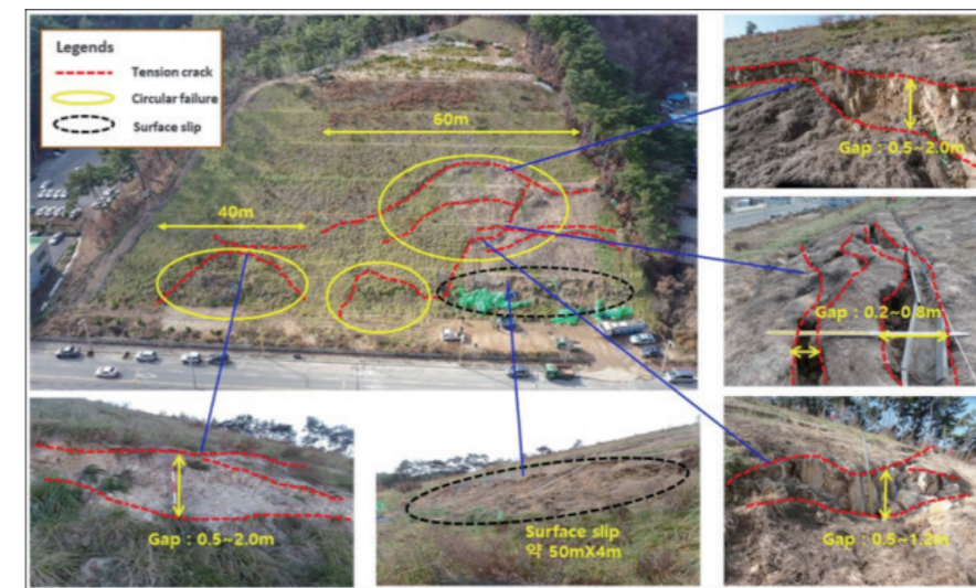
그림 3. Slope damage caused by land creep
